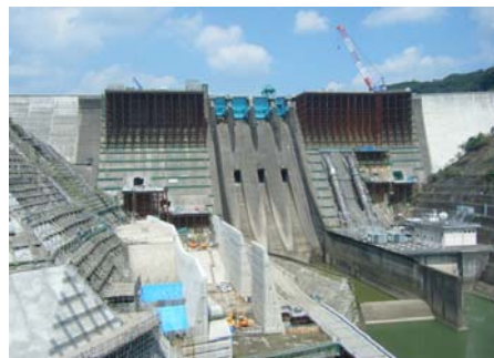
鶴田ダム再開発事業の全景
