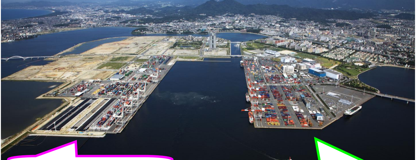
アイランドシティ コンテナターミナル
