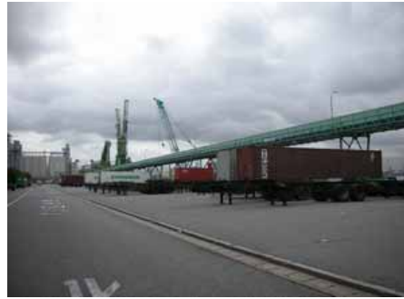
箱崎ふ頭野積場(シャーシ置場)
