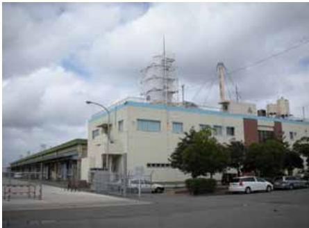
箱崎青果上屋管理棟
